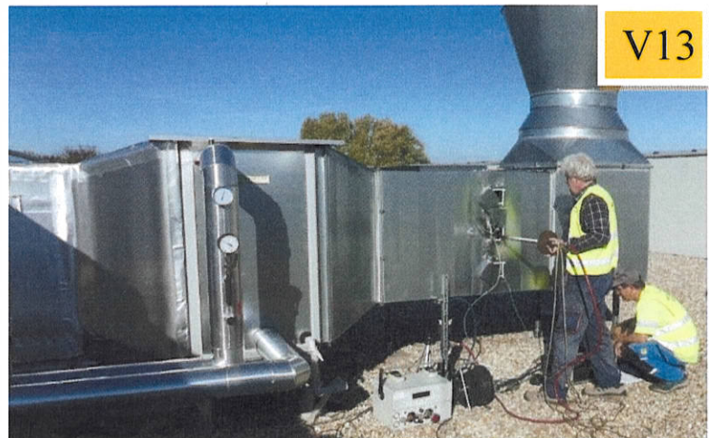
Obrázok č. 7 Schéma odsávania do výduchu V13 a umiestnenie meracích miest
